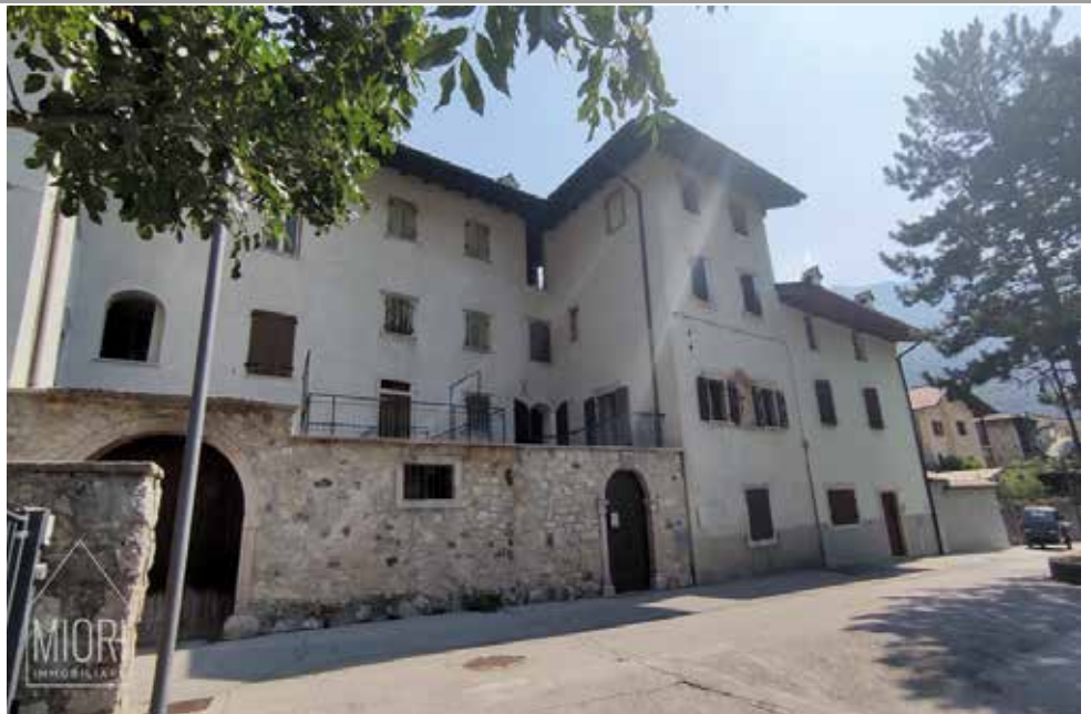
CAVEDINE centro paese , porzione di casa abitabile e indipendente, 4 piani con cortiletto, cantine, zona giorno, zona notte, mansarda al grezzo. Eventuali accessori e piazzale a parte. Euro 189.00
