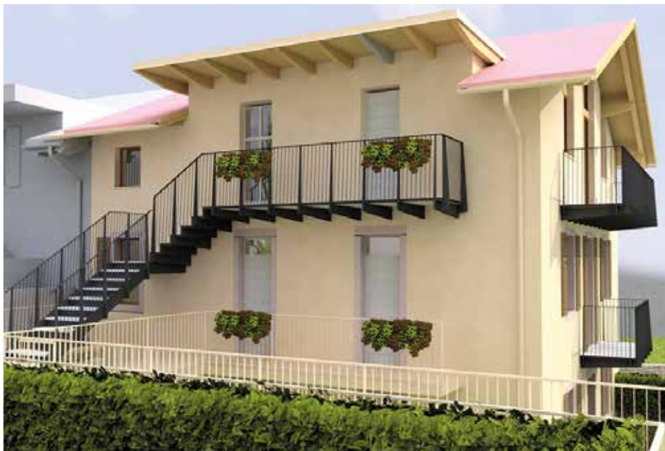
VEZZANO casa in fase di nuova ristrutturazione con 4 appartamenti acquistabili separatamente, terreno 3.000 mq, giardini, garage, posti auto, finiture a scelta! Info in ufficio
