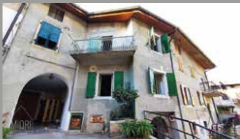
VIGOLO BASELGA casa indipendente in centro paese, da risanare ma abitabile. 4 piani di 70 mq ognuno, cantina, zona giorno, zona notte e soffitta, balcone e cortile. Euro 115.000
